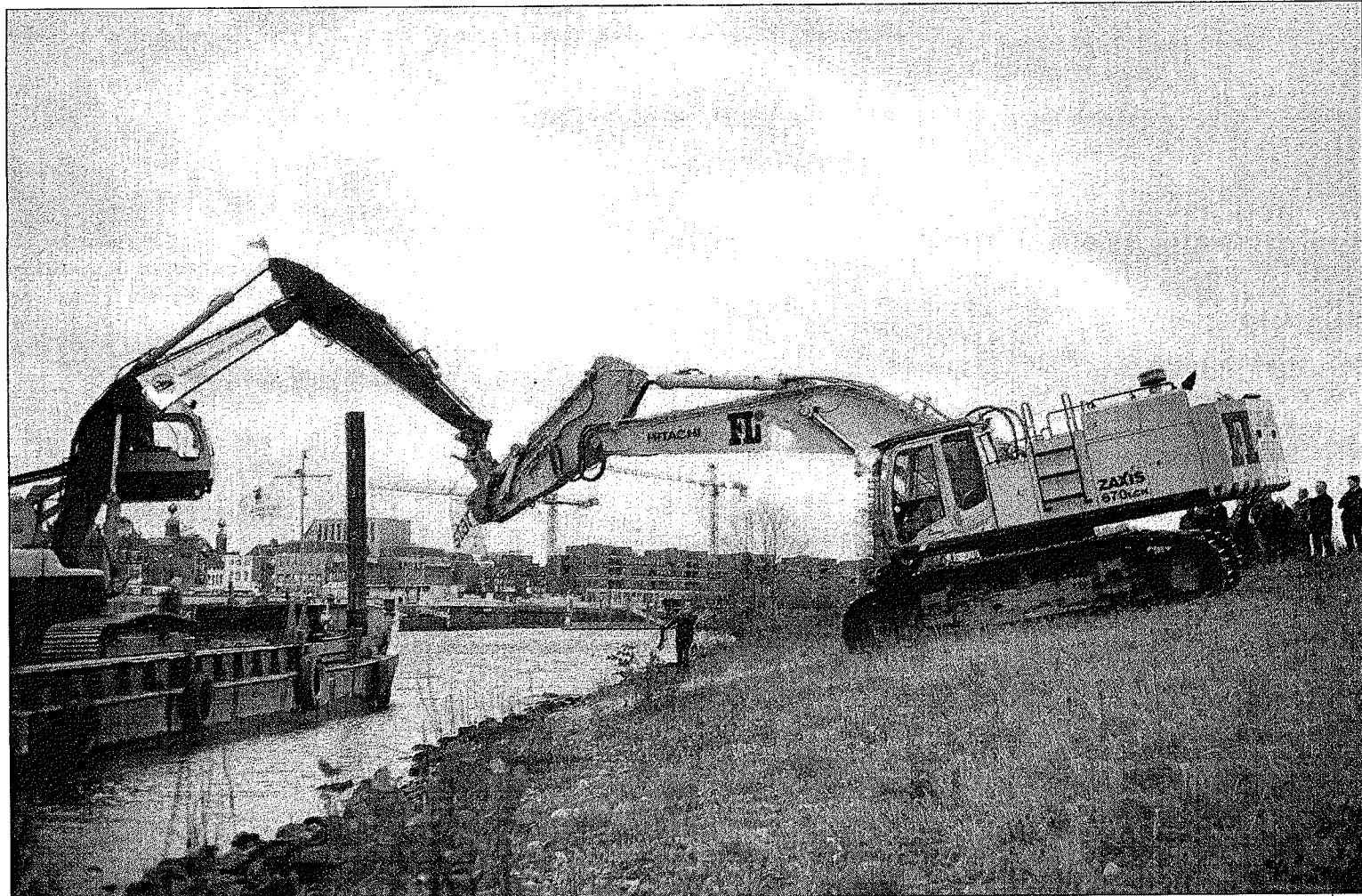
Gisteren werd de officiële aftrap verricht van de werkzaamheden in het Raaijweidegebied aan de Maas.
